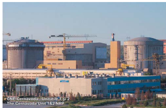
Fig. 5.2. CNE Cernavodă - Unitățile 1 și 2
