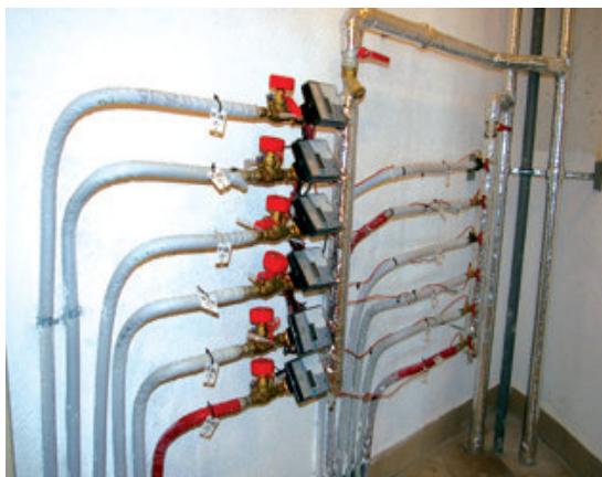
Figura 6.6. În interiorul unei încăperi tehnice de etaj, sunt ilustrate contoarele individuale de ET și conductele de încălzire separate pentru fiecare apartament, conectat la SACET (sursa: Fotografii Encon).
