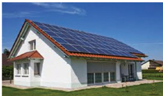
Figura 7.5. Sistem rezidențial fotovoltaic cu module cristaline. Capacitatea sistemului este de aproximativ 12 kW și ar produce 13.000 kWh anual (sursa: http://energyinformative.org/blog ).
