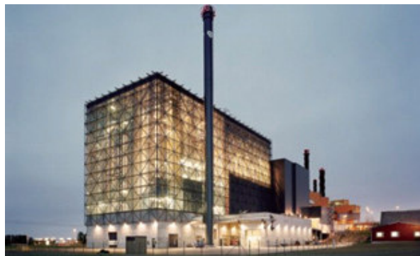
Figura 7.10. CET modern de incinerare a deșeurilor în apropiere de Linköping, Suedia. Capacitatea este de circa 24 tone de deșeuri pe oră, 65 MW energie termică pentru SACET și 19 MW energie electrică. (sursa: Usitall)
